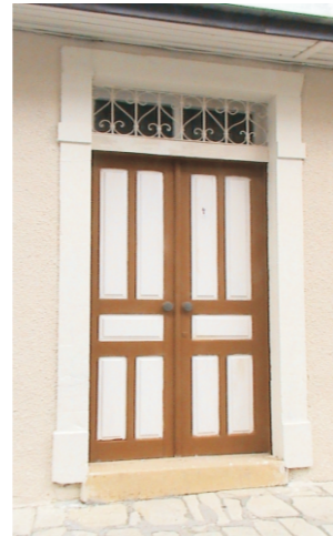
ΤΑΜΠΛΑΔΩΤΗ ΘΥΡΑ ΜΕ ΥΠΕΡΘΥΡΟ ΠΛΑΙΣΙΟ ΑΠΟ ΠΕΛΕΚΗΤΗ ΠΕΤΡΑ (ΣΥΝΤΗΡΗΜΕΝΗ)
